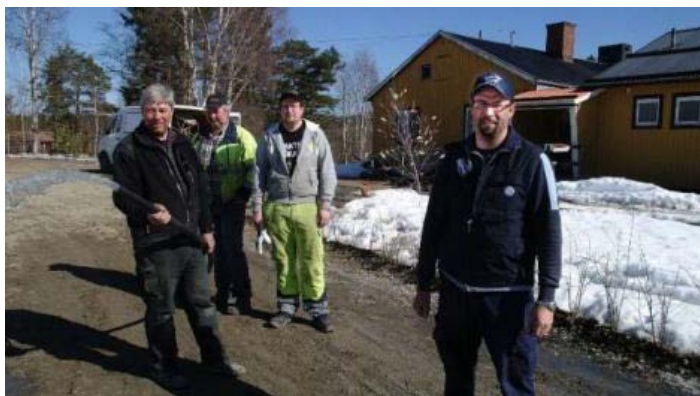
Johnny Bragde, Frösön, Göte Andersson, Tandsbyn, Stefan Andersson, Orrviken, och Hungegårdens nya delägare Jimmy Karlsson, Hunge, kollar vattenflödet i den nya berg- värmeanläggningen som håller på att installeras. Ingvar Ericsson
